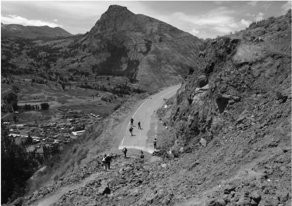
Figura 4. Deslizamiento de tierras que corta la carretera de acceso a uno de los complejos arqueológicos del Valle sagrado de los Incas, cerca de Cuzco, Perú. Septiembre de 2010 ©Juan Carlos Gutiérrez).
