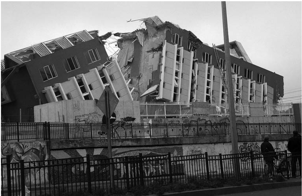
Figura 3. El edificio Alto Río de 20 pisos (Concepción, Chile) se vino abajo a consecuencia del terremoto del 27 de febrero de 2010 (©Claudio Núñez).
